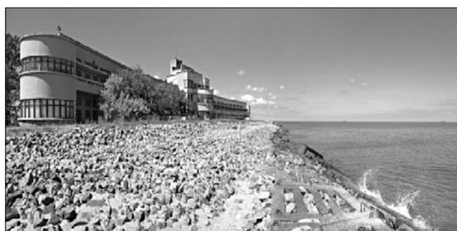
Fig. 2. Sanatoriul maritim de tuberculoză osoasă din Bugaz (construit în 1936 și inaugurat la 20 iunie 1937 de către Regele Carol al II-lea, arhitect – Angelo Viecelli).
